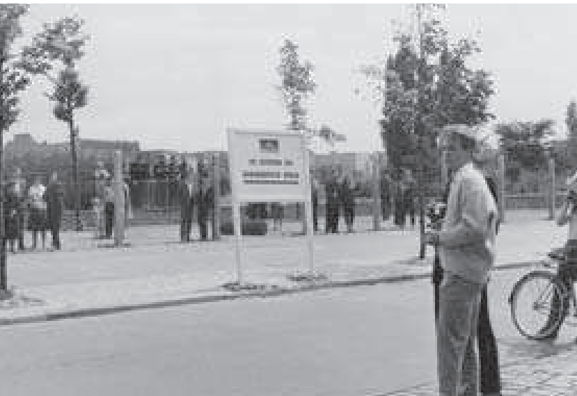
Erste Grenzsicherungsmaßnahmen Ostberlins für den Bau der Mauer an der Ebertstraße, 13. August 1961, 12 Uhr.
